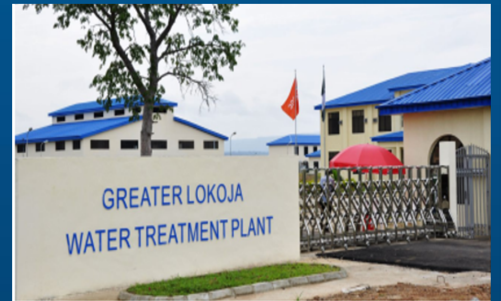
尼日利亚LOKOJA制水工程 Nigeria's LOKOJA Water Treatment Project
